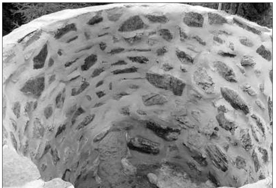
La chalchera in Uina Dadaint es gnüda renovada.
